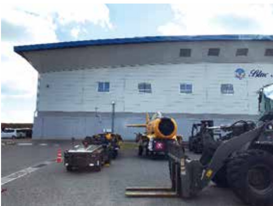
4.5mかさ上げされた格納庫
